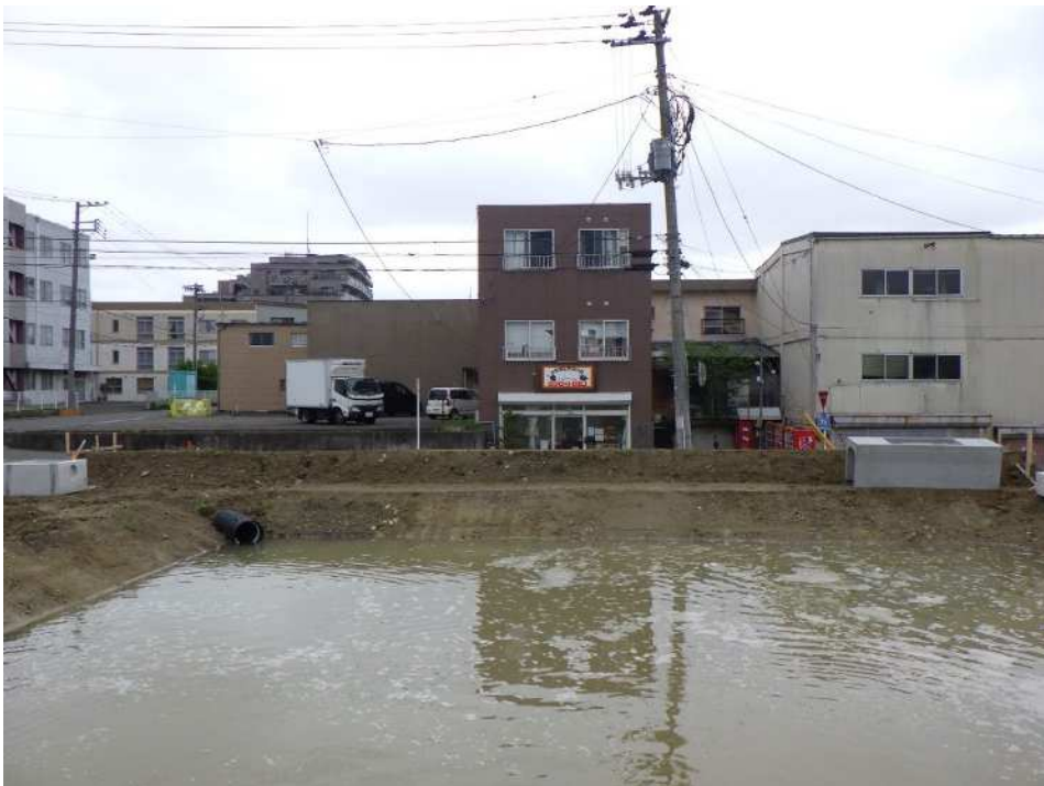
写真 6.4-1(2) 仮設沈砂池 A-1, 2 の水位状況 (令和5年5月8日撮影)
