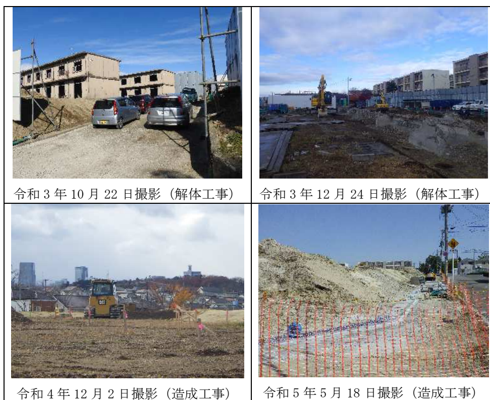
写真 3-1 工事の実施状況
