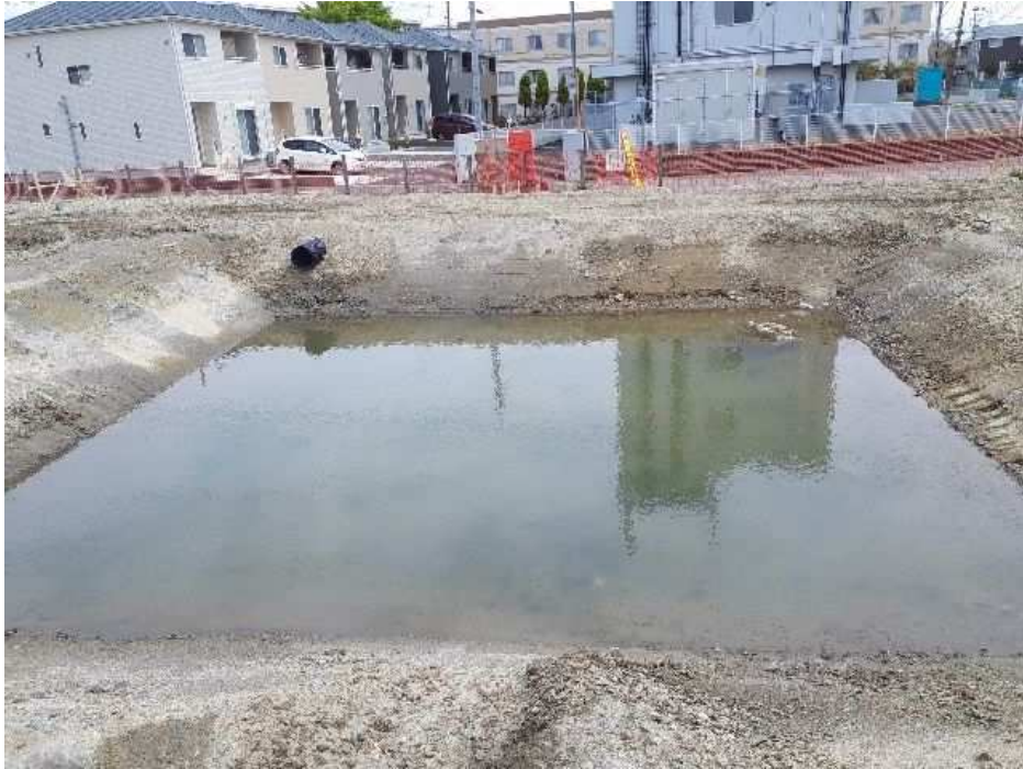
写真 6.4-1(1) 仮設沈砂池 A-3 の水位状況 (令和5年4月17日撮影)
