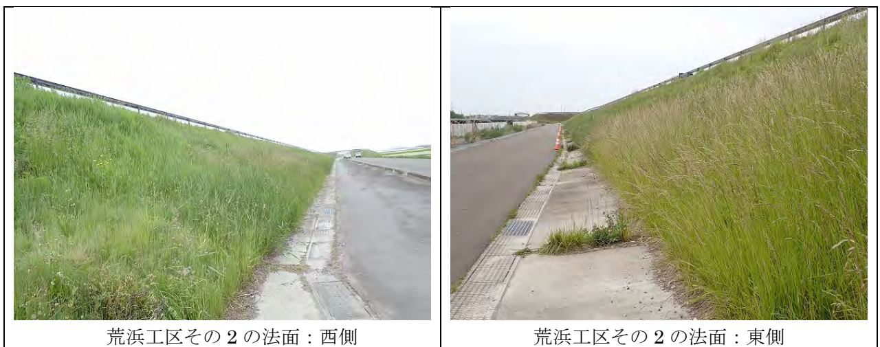
写真 1-2 荒浜工区（その2）の法面の状況
