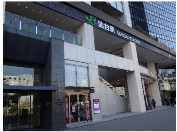
④ 駅前広場より低層部
