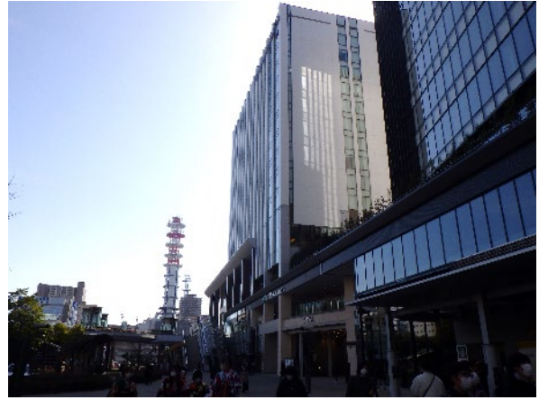
② 駅前広場北側より全景
