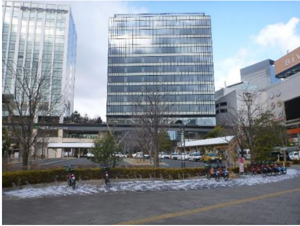
①駅前広場よりオフィス棟正面
