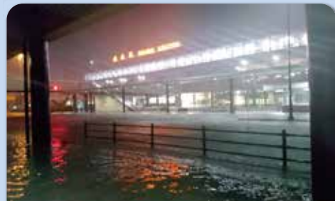
令和元年 (2019 年) 10 月の台風により、道路が冠水しています。(仙台駅西口)
