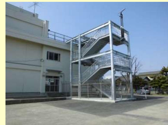
屋外津波避難階段 （鉄骨造）
