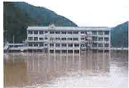
H26. 8 避難所2階の浸水(徳島県)
