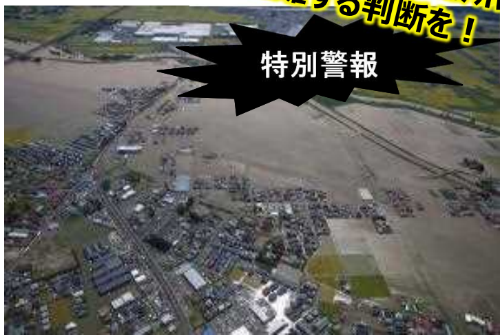
2015(H27)年9月関東・東北豪雨(台風第18号等) 大崎市・渋井川周辺の状況(鳴瀬川水系) 出典: 国土地理院
