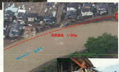
河岸侵食による家屋の流失 〔写真提供／西日本新聞社〕
