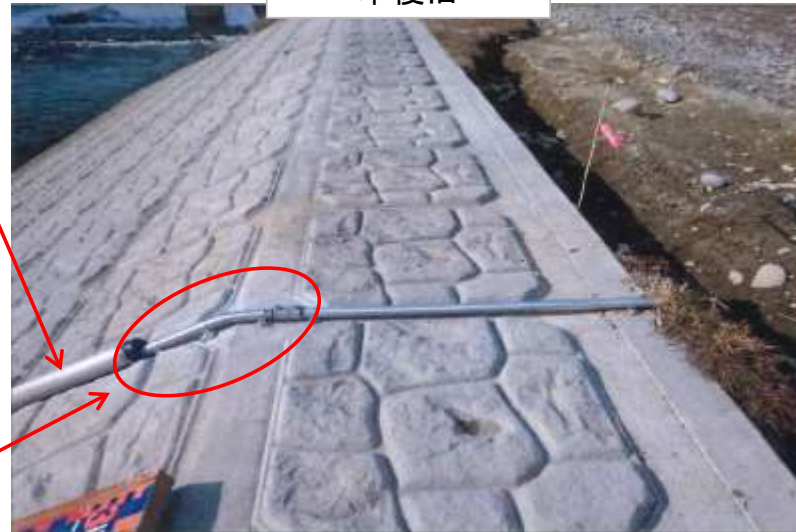
既設センサーを新しいセンサーに交換 プルボックスをステンレス管に変更
