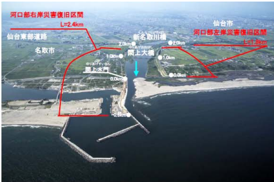
復旧状況斜め写真(平成26年8月24日撮影)
