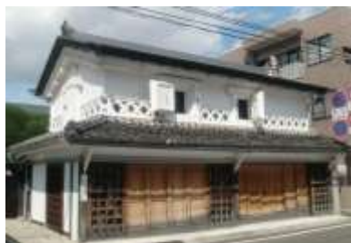
旧丸木商店 若林区南材木町
