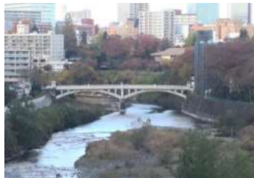
広瀬川にかかる橋りょう(霊屋橋)
