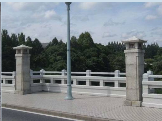
▲防護柵（バルコニー部）
