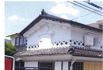
外観の保全への助成 (旧丸木商店震災復旧)
