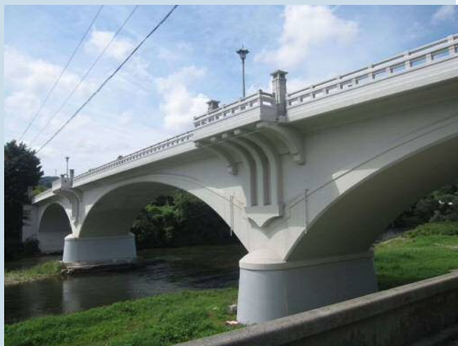
▲左岸下流側堤防より大橋を望む
