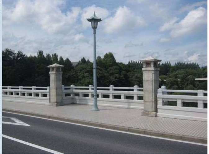
▲防護柵（バルコニー部）
