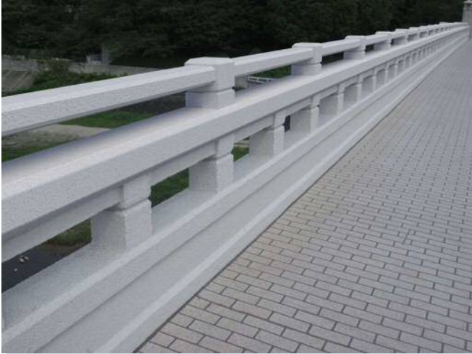
▲防護柵（一般部）
