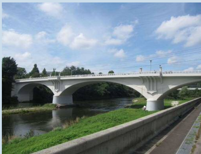
▲左岸下流側堤防より大橋を望む
