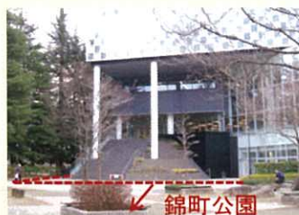
隣接する公園とつながる 開放的なつくりの建築物
