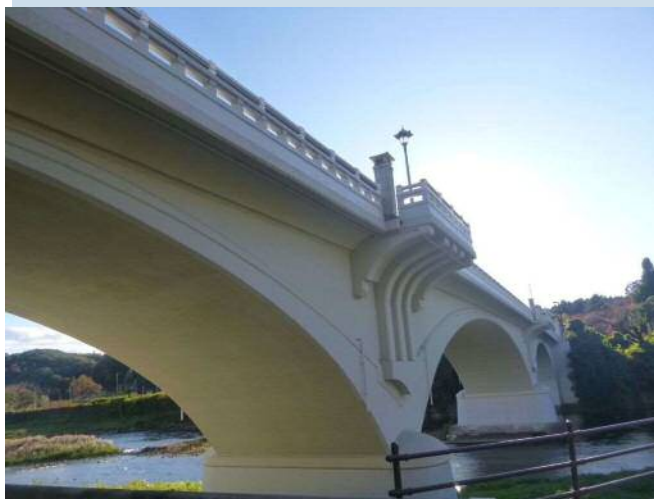
▲左岸上流側堤防より大橋を望む
