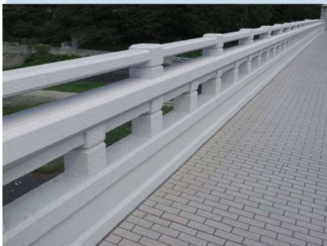
▲防護柵（一般部）
