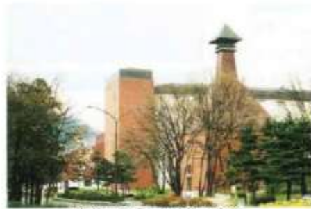
自然に配慮した建物の意匠 （ニッカウスキー仙台工場）
