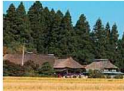
田園地帯の屋敷林に囲まれた住宅（根白石）
