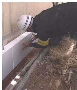
外壁の断熱化工事
