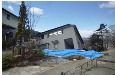
地すべりを起こした住宅地
