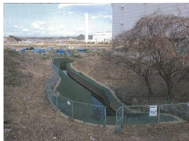
薄ヶ沢水路法面对策
