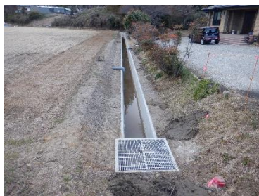
野村水路改修
