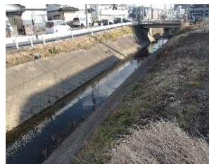
水路土砂浚渫後
