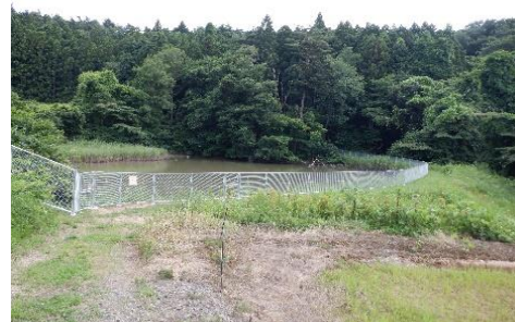
ため池安全柵設置
