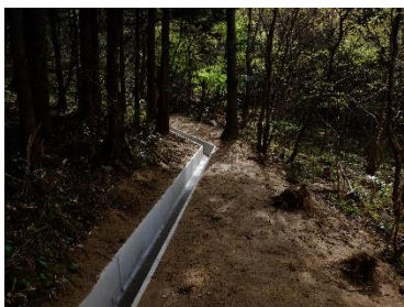
新川早坂水路改修
