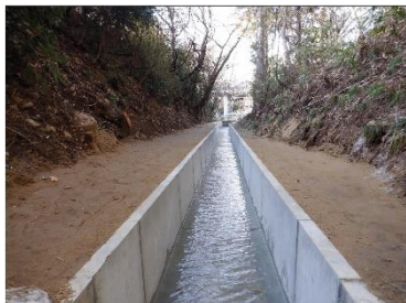
根白石大堰水路改修
