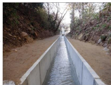
水路整備施工後
