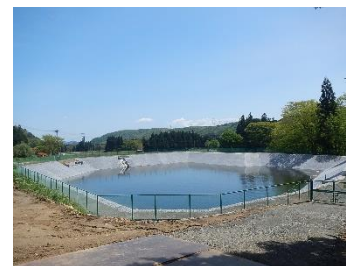
ため池改修状況
