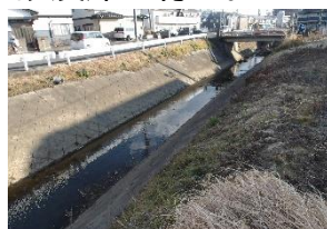
水路土砂浚渫後
