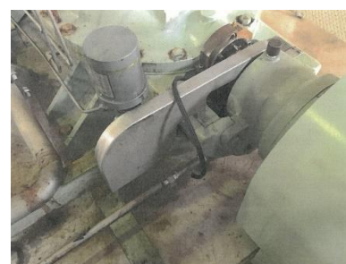
ベルト切断 修繕前
