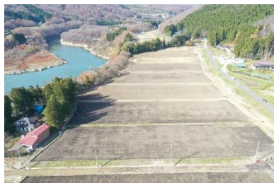
大倉日向地区 整備後
