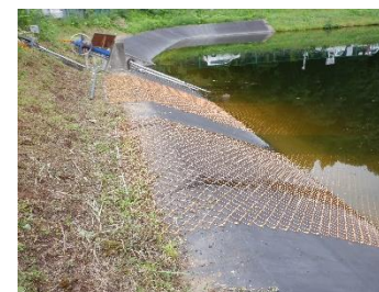
安全ネット設置状況
