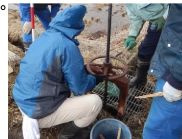
水路ゲートの点検 (太白区秋保町)
