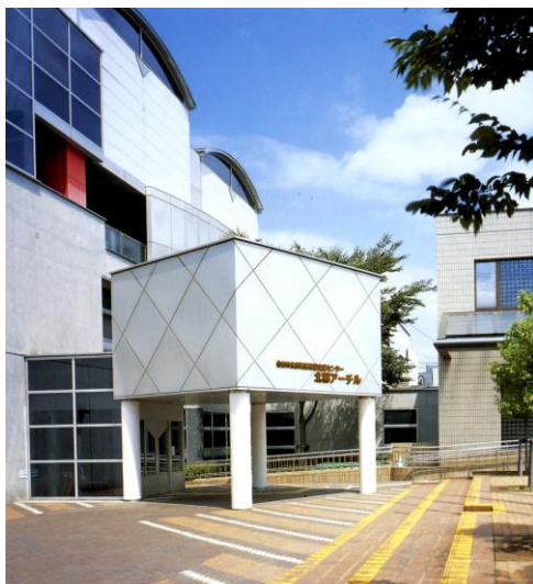
センター事務室入口
