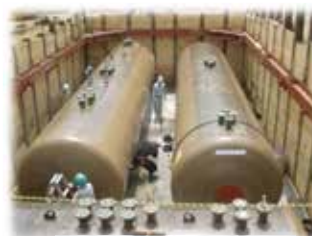
設置時中間検査
