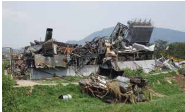
H30.7月豪雨により浸水被害を受け水蒸気爆発したアルミ工場
