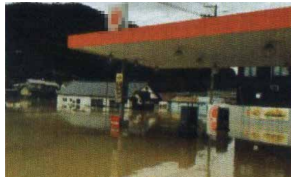
浸水被害を受けた給油取扱所 出典:危険物施設の風水害対策のあり方に関する検討報告書(令和元年度中間報告)
