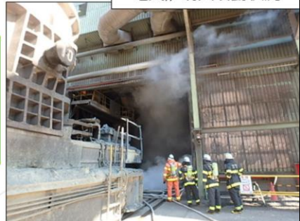
電気炉消火活動状況
