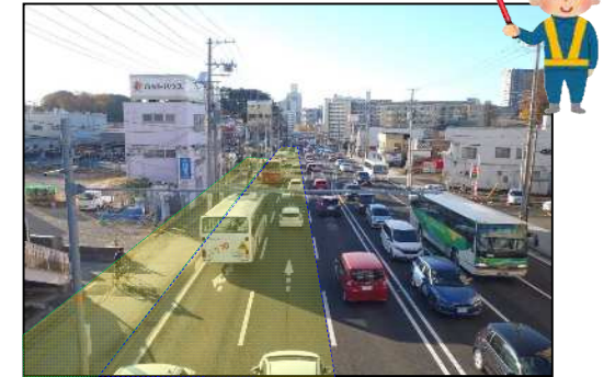
↑ 台原歩道橋から昭和町交差点方向を望む
