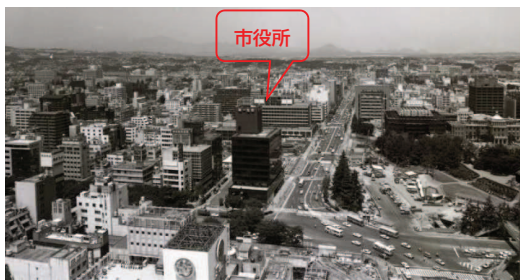
東二番丁通と勾当台通との直線化（クランク解消）工事（昭和 60 年頃）
