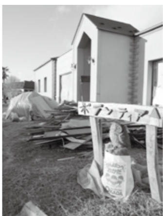
自宅敷地内の貸家をボランティアハウスとしても開放している吉田さん。手前の家には、震災前に両親と妹さんが住んでいましたが、完全には修繕できていない状況のようです
