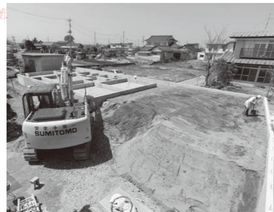
現在建設中の住居基礎
