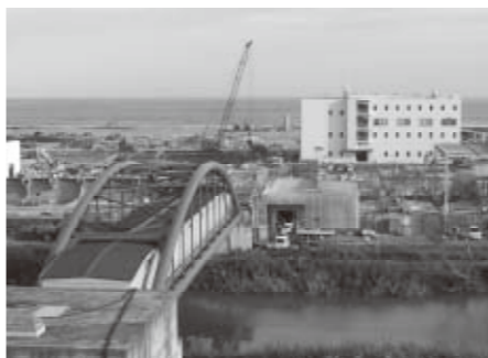
解体と新築工事が同時に進む現在の南蒲生浄化センター。津波は写真右の建物が見えなくなる高さには達しました
