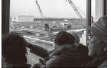
▶浄化センターの4階から、海岸堤防工事の様子を見学しました
