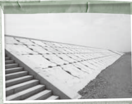
深沼海岸から望む海岸堤防
