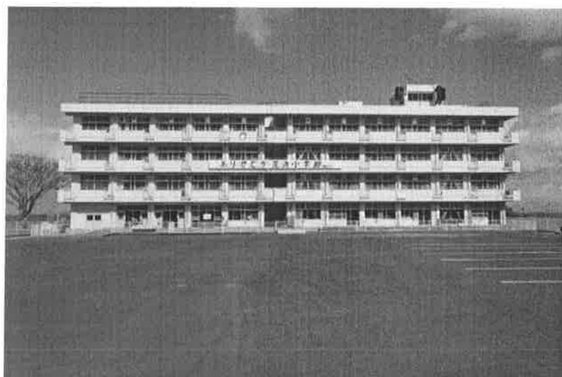
震災遺構 仙台市立荒浜小学校
