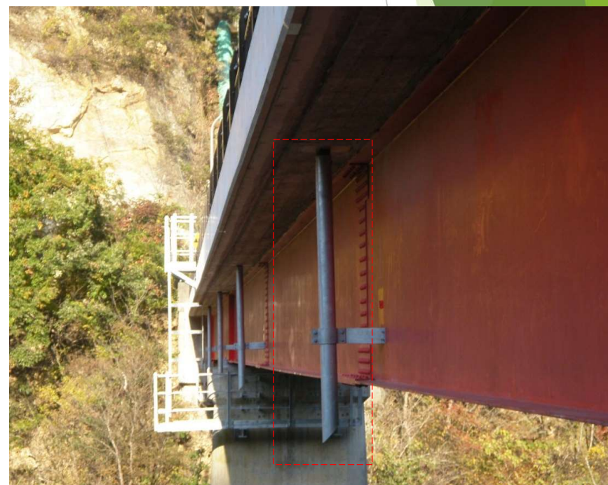
苦地橋（青葉区）・施工後
