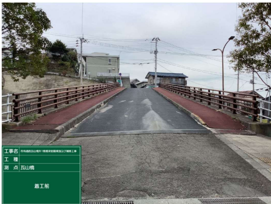
瓦山橋（青葉区）・施工前
