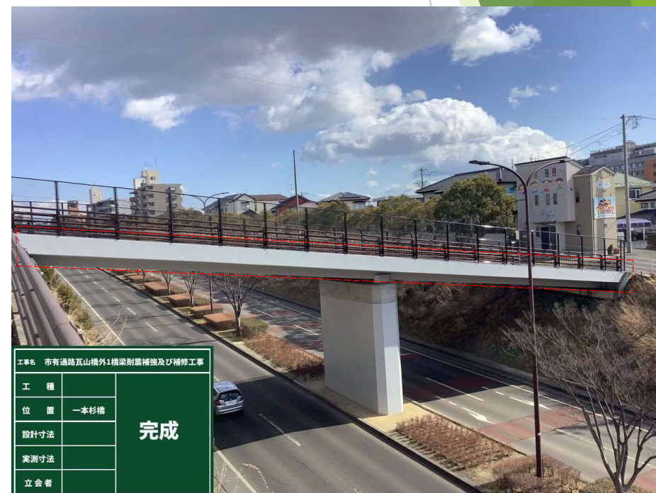
一本杉橋（青葉区）・施工後
