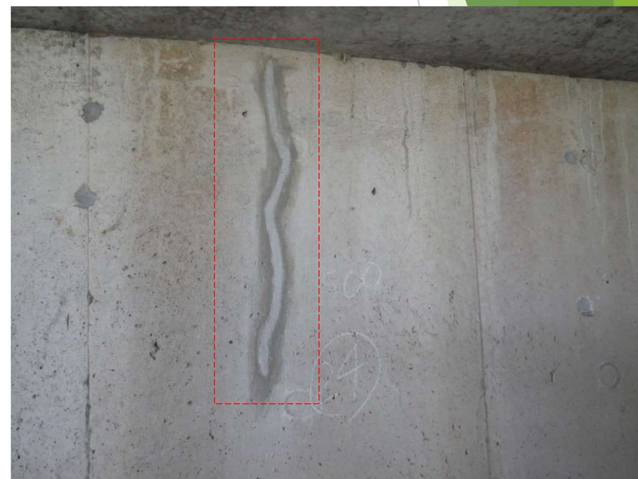
城前大橋（泉区）・施工後
