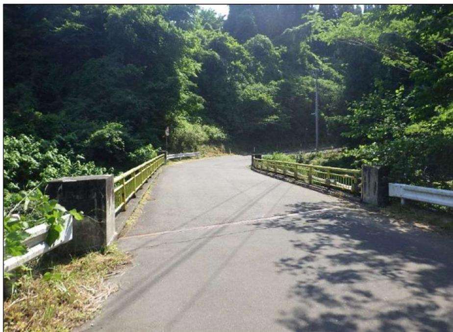
国久橋（太白区）・施工前
