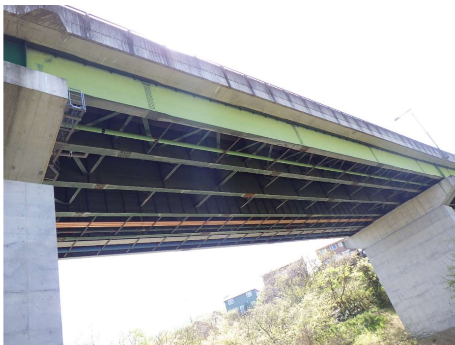
新早坂下橋（泉区）・施工前
