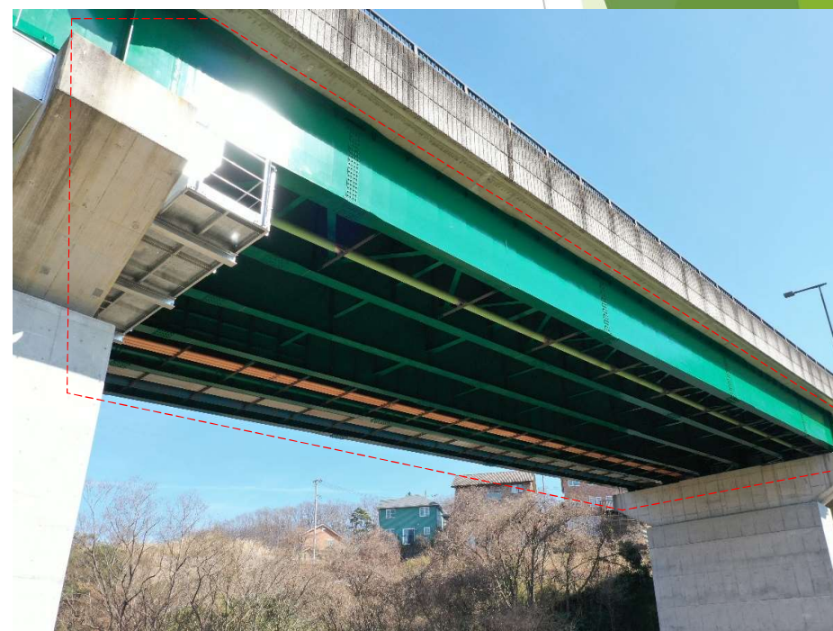
新早坂下橋（泉区）・施工後
