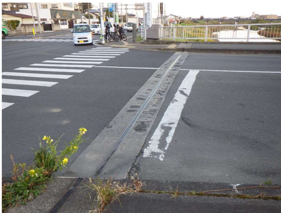
今市橋（宮城野区）・施工前
