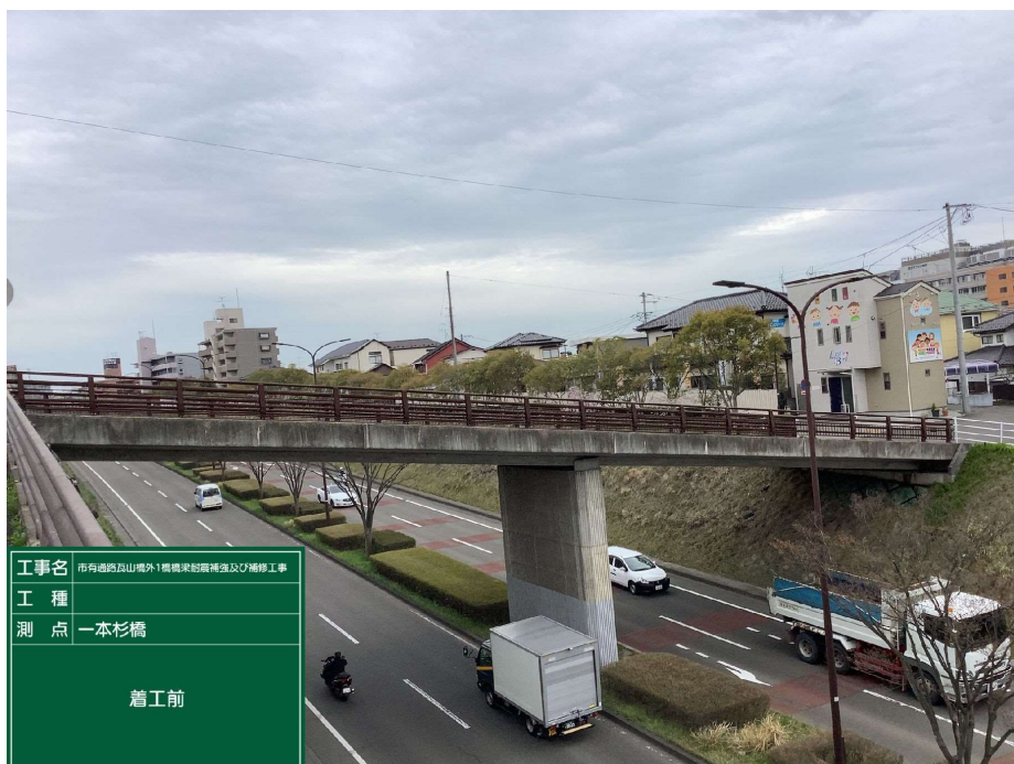
一本杉橋（青葉区）・施工前
