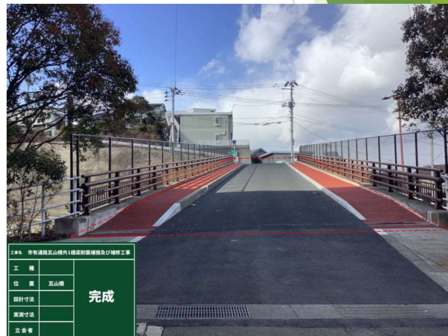
瓦山橋（青葉区）・施工後
