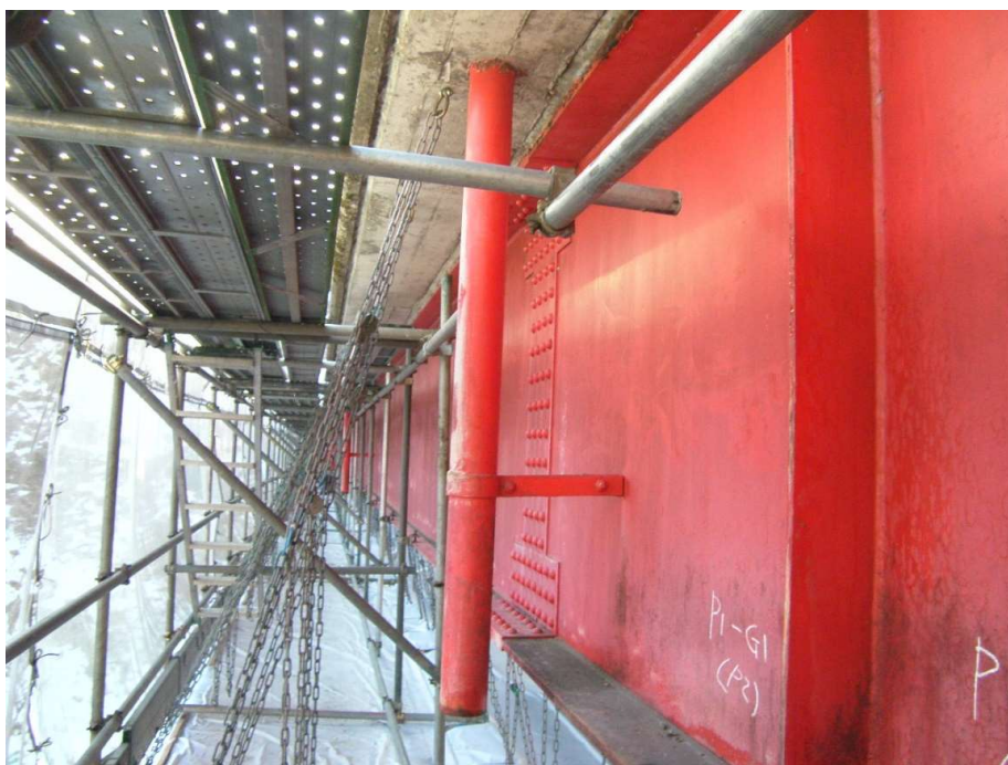
苦地橋（青葉区）・施工前
