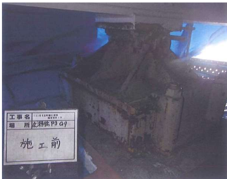
広瀬橋（若林区）・施工前
