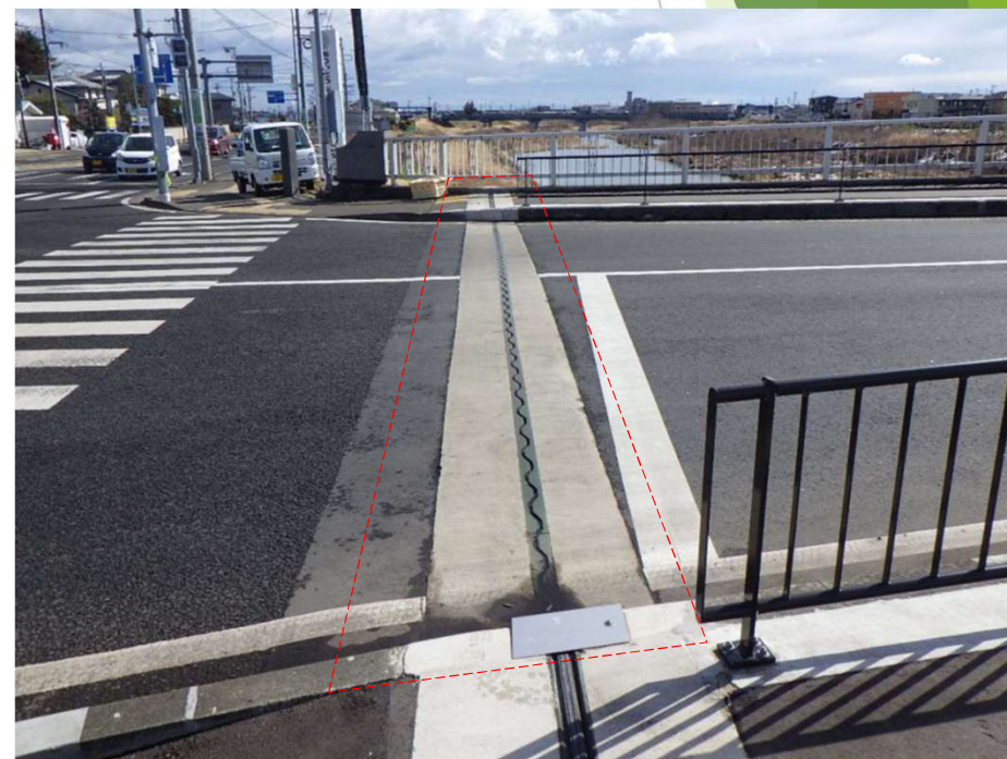
今市橋（宮城野区）・施工後
