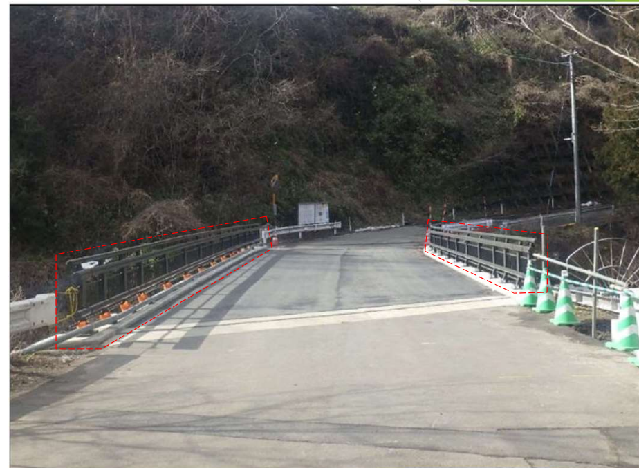
国久橋（太白区）・施工後
