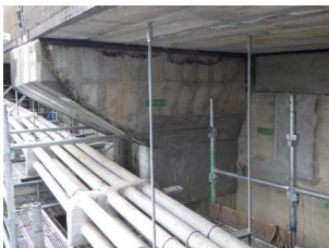
【STEP1】橋梁補修工事中
