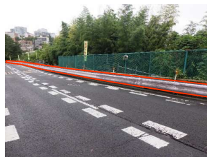
【STEP2】防護柵交換箇所
