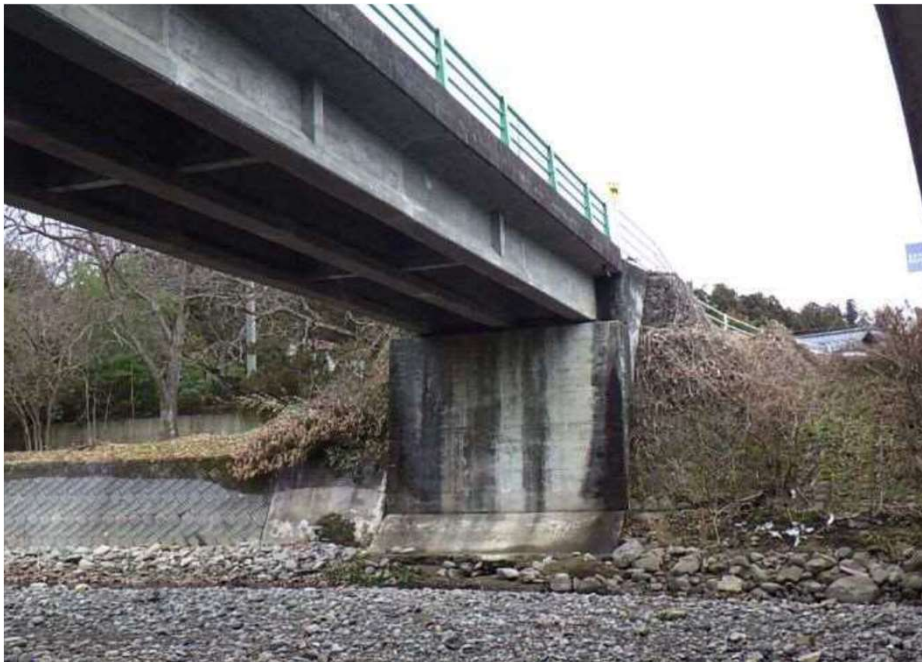
壇ノ原橋側道橋（泉区）・施工前
