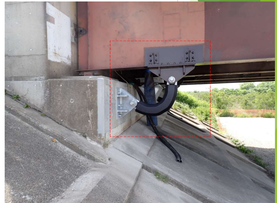
高砂橋（宮城野区）・施工後
