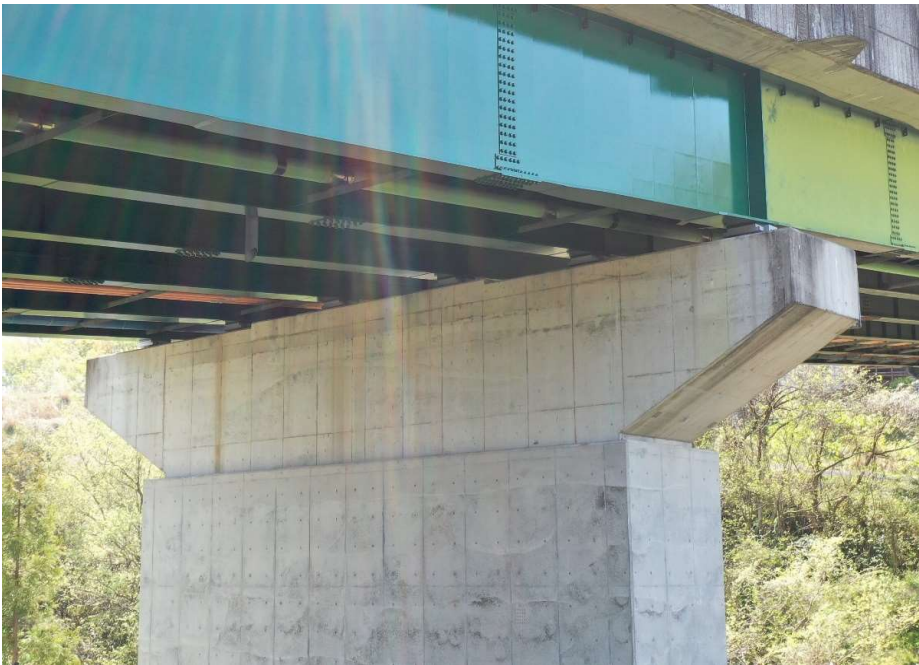
新早坂下橋（泉区）・施工前
