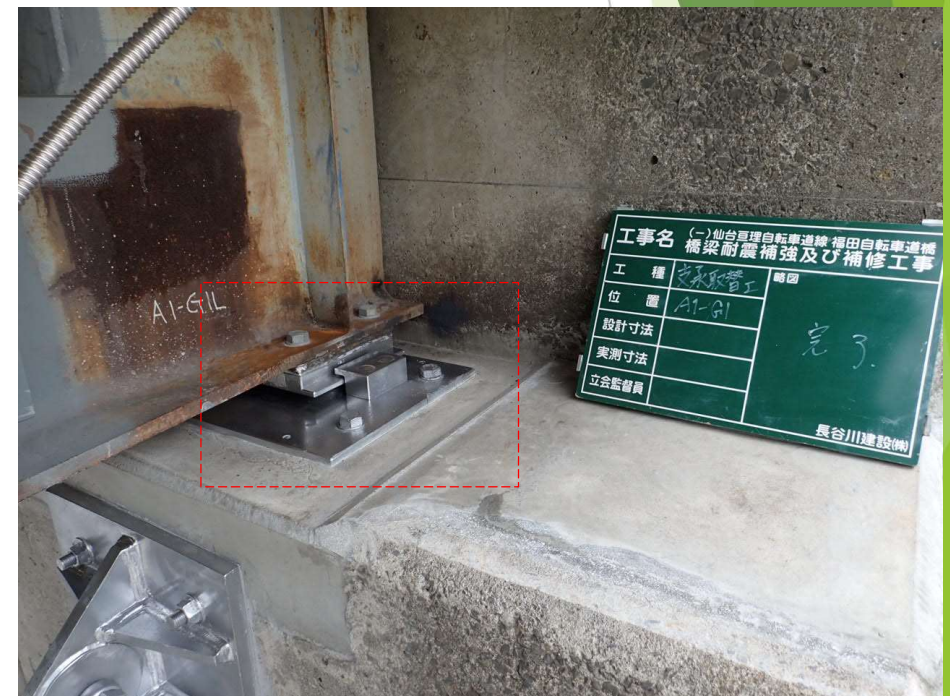
福田自転車道橋（宮城野区）・施工後
