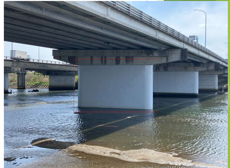
高砂大橋（宮城野区）・施工後
