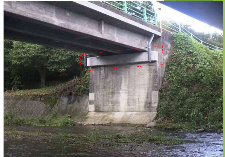
壇ノ原橋側道橋（泉区）・施工後
