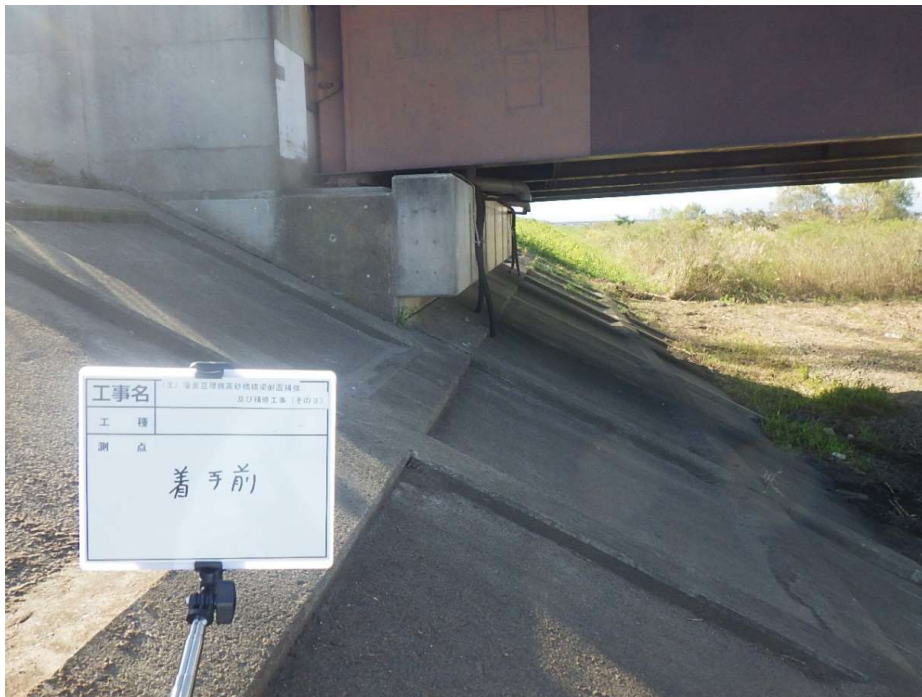
高砂橋（宮城野区）・施工前
