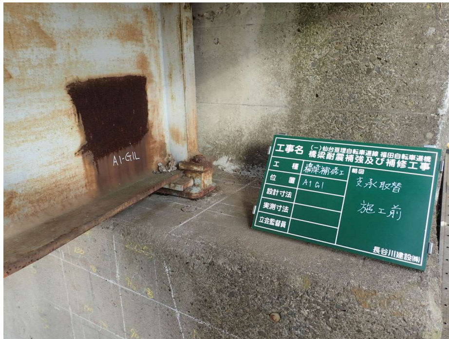
福田自転車道橋（宮城野区）・施工前
