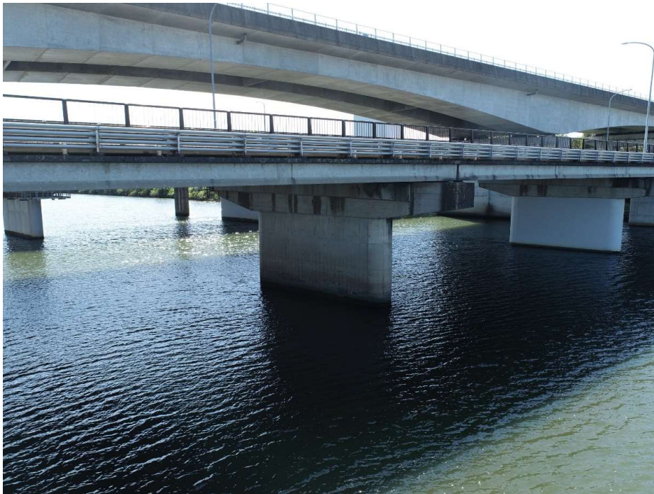
高砂大橋（宮城野区）・施工前
