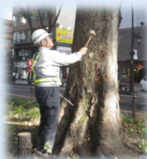
◀外観調査の様子
