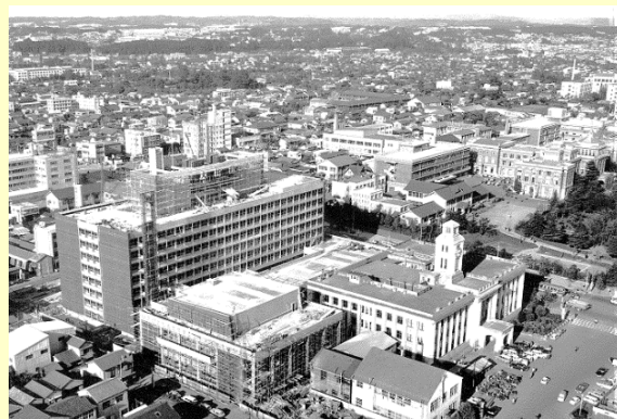
市役所本庁舎 昭和40年完成
