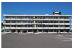
震災遺構仙台市立荒浜小学校
