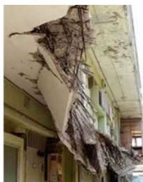
マンションの2階廊下部分が崩落した事例
