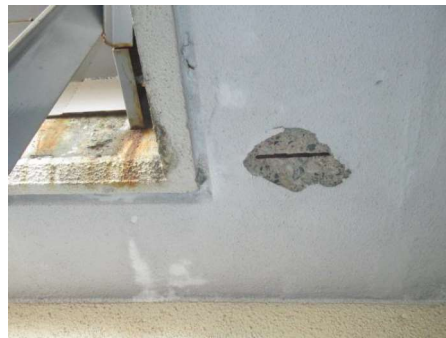
ピロティ天井
