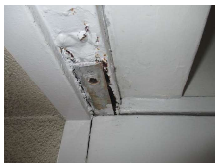
7階非常扉上部
