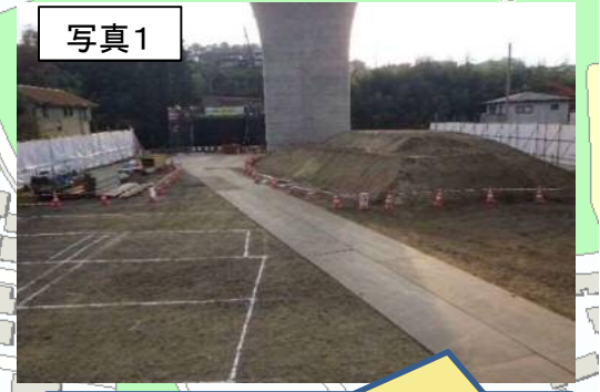
粉塵等の飛散防止のため、敷鉄板・防塵シートの仮囲いを設置しています。
