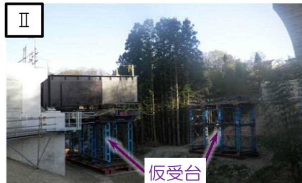
橋桁をボルトでジョイントしながら、橋台～橋台まで到達させていきます。
