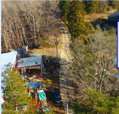
進捗写真 【南から北側を撮影】 (上空から撮影) H30.12.22 着手前
