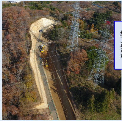
進捗写真 【南から北側を撮影】 (上空から撮影) R1.11.22
