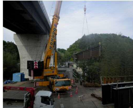
橋桁をボルトでジョイントしながら、橋台～橋台まで到達させていきます。
