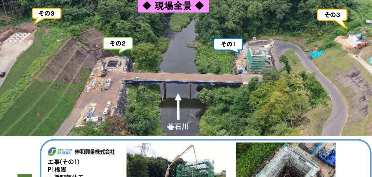
• 橋脚躯体工 コンクリート打設 (9回中3回目) 鉄筋組立(4リフト目)
