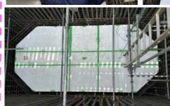
従来は足場と型枠を設置し、 コンクリートを打設した後、 撤去していましたが、EPS 工法を採用することで施工 の省力化と安全性を向上す ることができました。 高品質な橋脚をつくるため、 発泡スチロールが大活躍し
