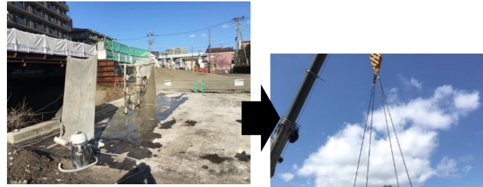
橋桁の切断状況
