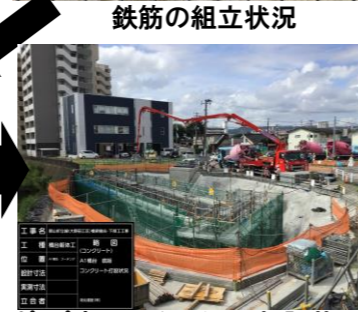
ポンプ車によるコンクリート打設状況
