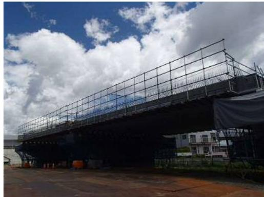
その3工事主桁架設完了(県道荒井荒町線沿いから撮影)
