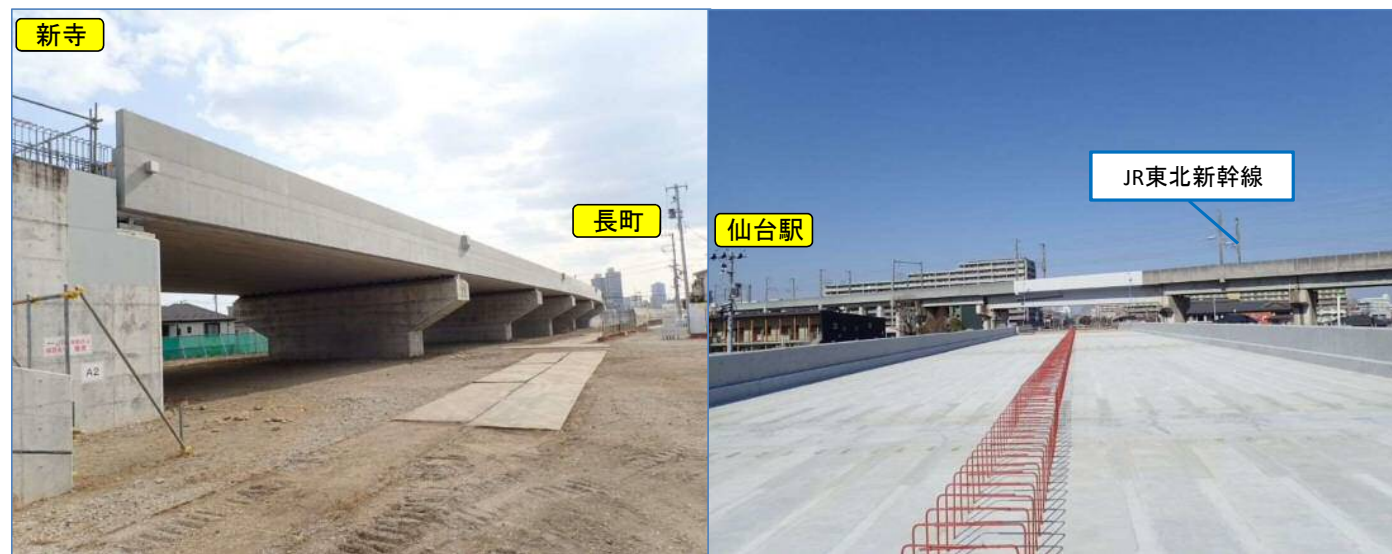
完成した橋（3月8日）
