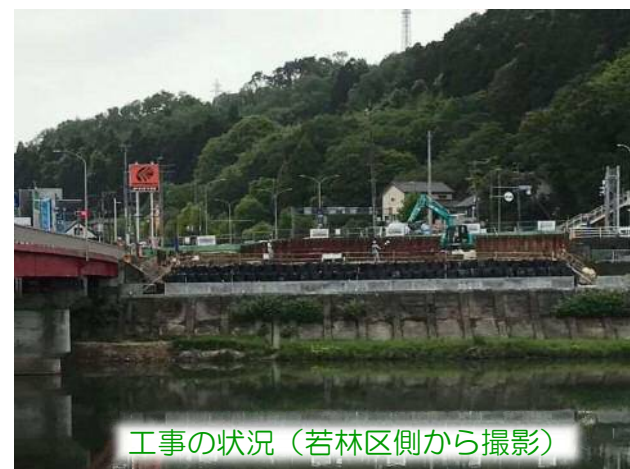
土留めの施工状況
