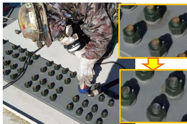
▲約10万本のボルトを専用の機械で締め付けた後、手作業でサビ落し、塗装します。
