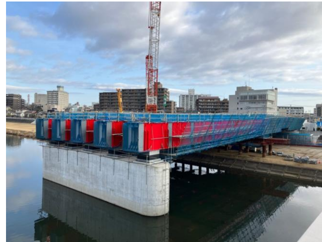
▲橋桁の架設は、天候に恵まれて予定どおり完了しました。
