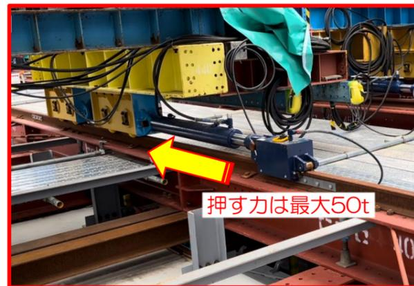
▲ジャッキは電子制御により、10台すべてが連動しています。1台で50tまで押せます。
