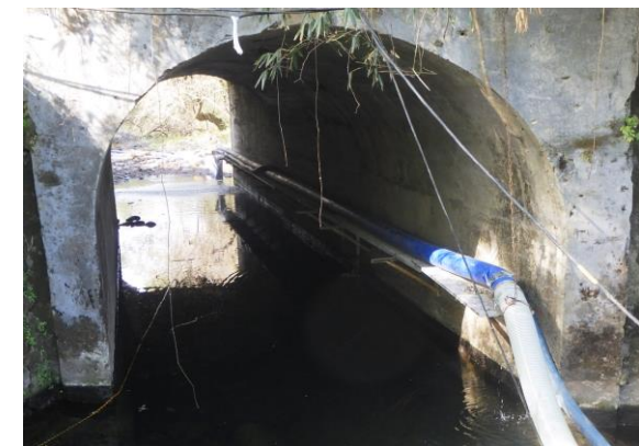
現況水路(水路補修工事)
