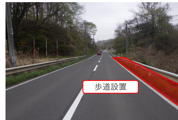
現況道路(歩道設置工事)
