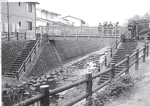
交路木橋の全景
